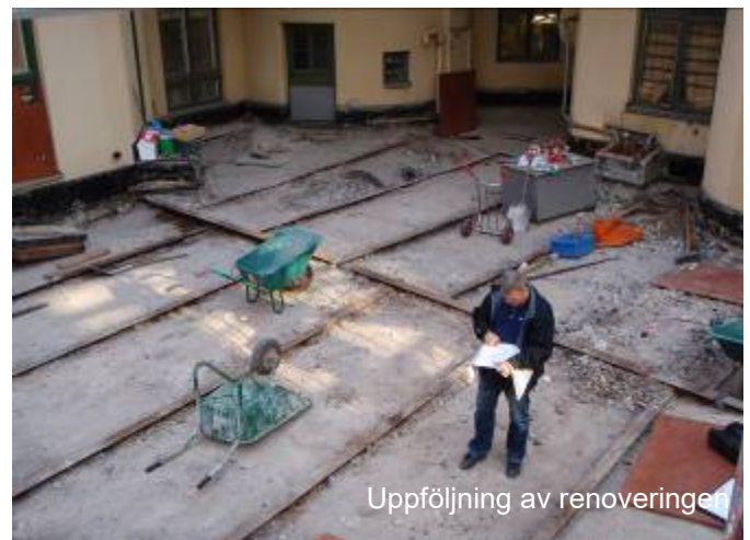
Här renoveras en gård. Beläggning och fyllning är bortforslad. De bärande balkarna är delvis frilagda för vidare kontroll och eventuell förstärkning.
